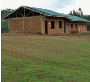
Noch im Rohbau, soll aber noch in 2011 fertig gestellt werden: Die Schule in Mulamba/Panzi, für die wir uns auch in Zukunft stark machen.
